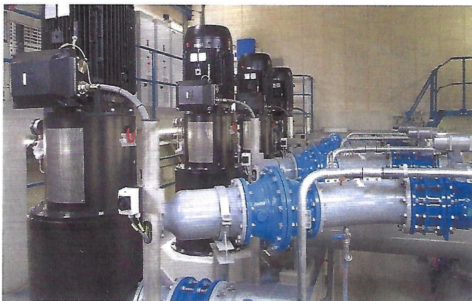
Afbeelding 1. Resonantievrije, verticale opstelling.
